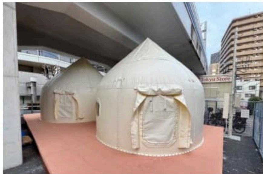
▲現地工事の様子
